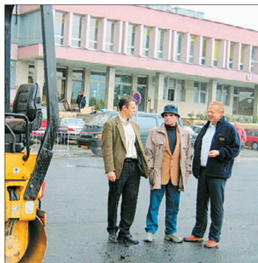
Po dokončení úprav parkoviště zkontrolovali provedené práce (zleva) Ing. Josef Pešl, místostarosta Miloš Michálek a Jaroslav Balcar. Foto J. Zuziaková
